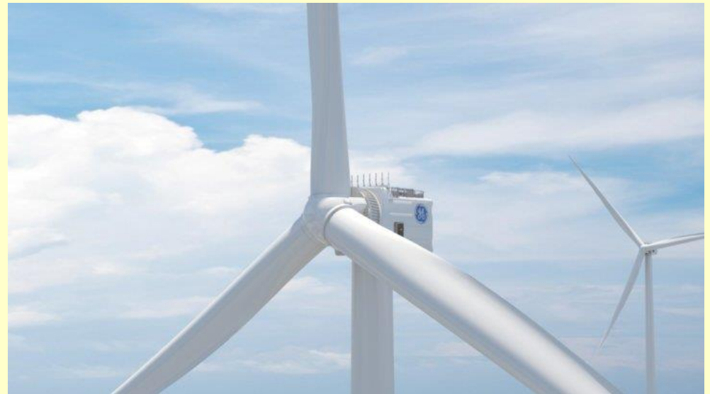
Připravovaná turbína GE Renewable Energy – 12 MW, 260 m
