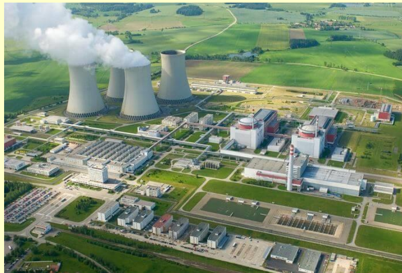
Jaderná elektrárna Temelín
