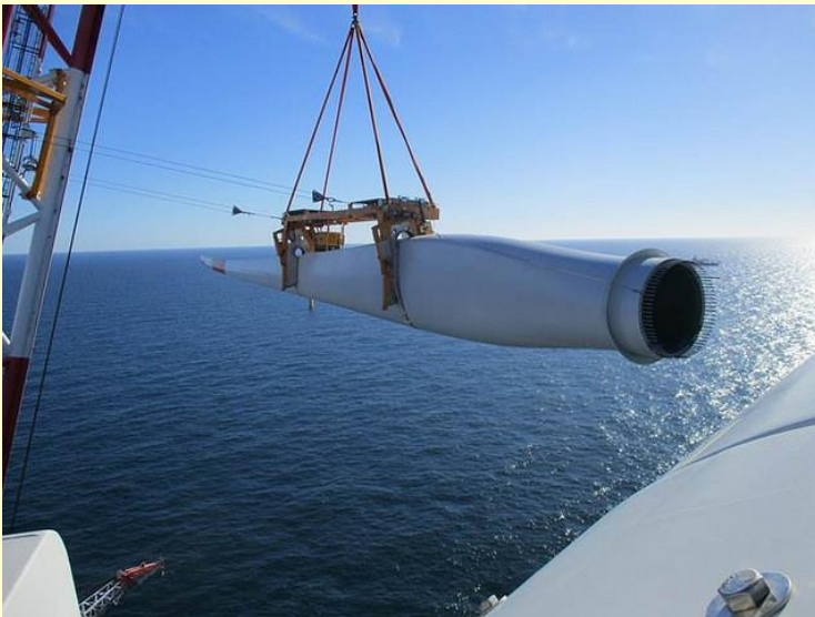
Instalace mořské větrné turbíny
